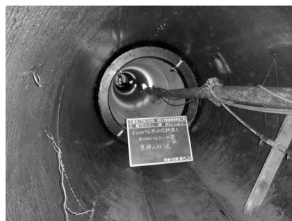
写真－5 \phi 1,000\text{mm} ヒューム管挿入状況
