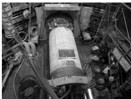
写真-8 ヒューム管推進状況 [参考資料]
