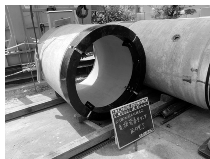
写真－3 先頭管ゴム養生リング取付け状況
