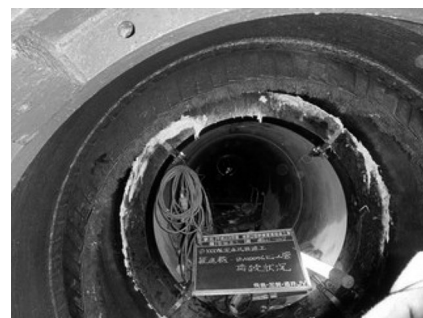
写真－6 掘進機・ヒューム管接続状況
