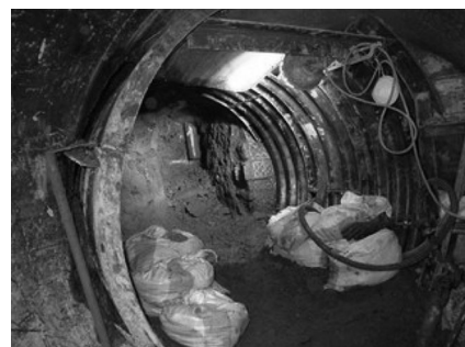
写真-14 第2回目障害物撤去状況 (下水管路部)
