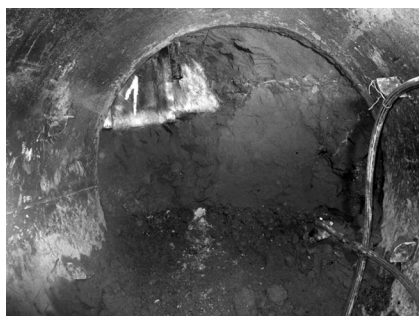
写真-13 第2回目障害物撤去状況 (下水管路部)
