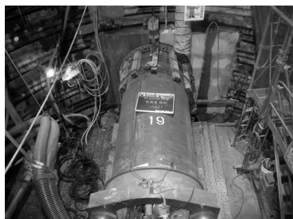
写真-7 鋼管推進状況 [参考資料]
