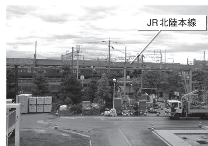
写真-1 No.1発進ヤード 全景
