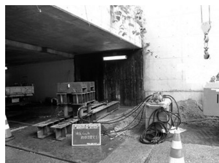
写真-11 第1回目障害物撤去状況 (JR軌道高架下)
