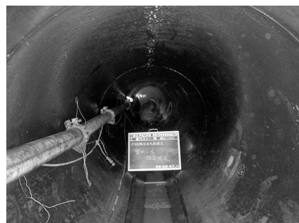
写真－4 鋼管内レール材取付け状況
