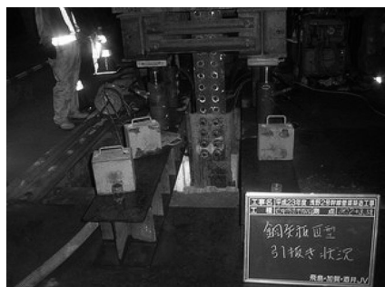
写真-12 第2回目障害物撤去状況 (下水マンホール部)
