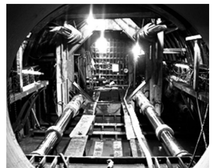
写真-3 推進設備
