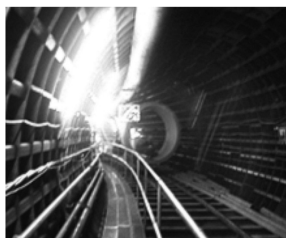
写真-1 推進管の坑内運搬状況
