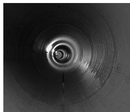
写真-9 管内状況
