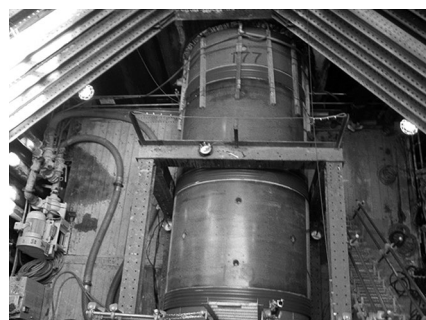
写真－6 推進状況
