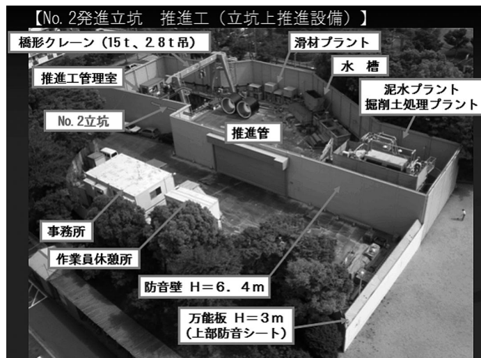
写真－5 発進部設備状況
