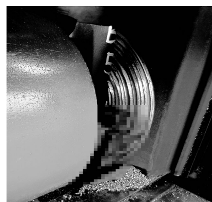
写真－12 鋼矢板凸面切断
