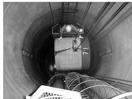
写真-1 推進管吊り降ろし
