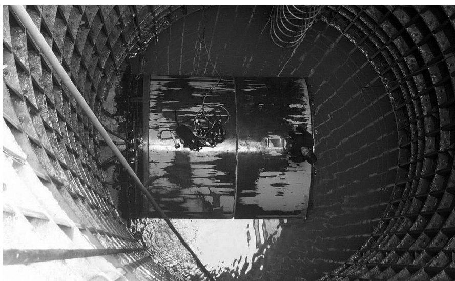
写真-7 水中到達 揚水後(掘進機押し出し完了)
