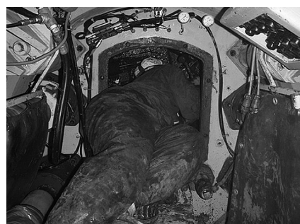
写真－10 点検扉開口、管内作業状況
