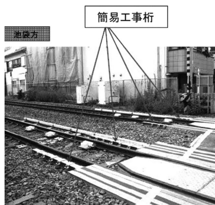
写真－8 簡易工事桁の設置状況
