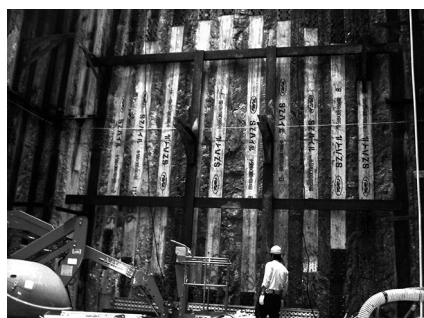
写真-5 立坑掘削完了時の状況
