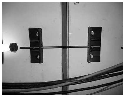
写真-3 推進管材にアンカを取付けて目地開口制限装置を組み立てる方法後施工アンカでも可能だが管材保護の面からはインサートアンカが望ましい
