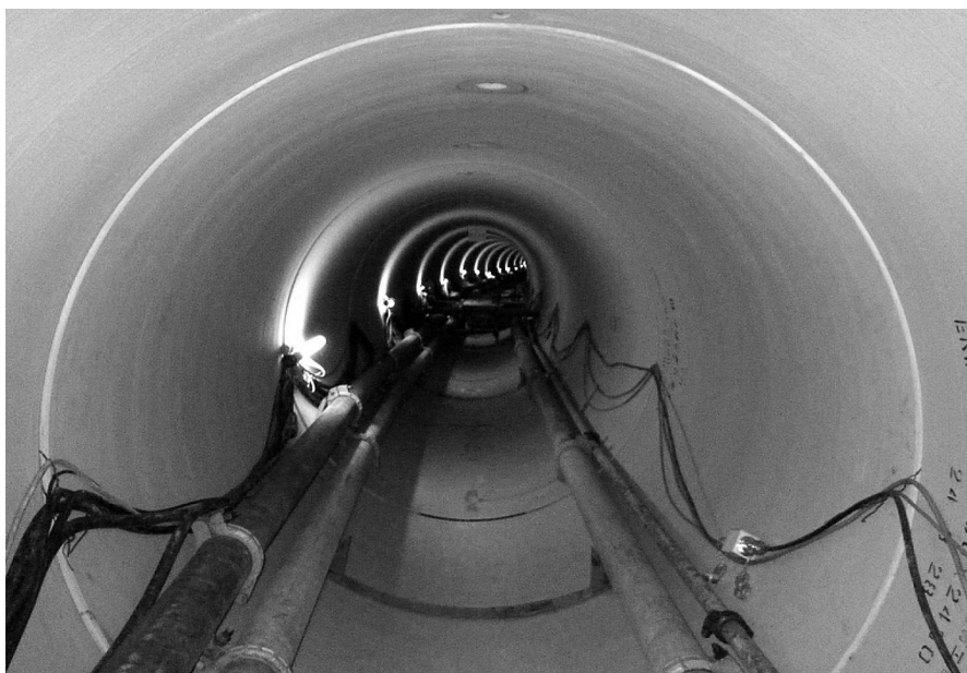
写真-1 曲線推進施工例
