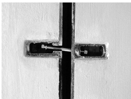
写真-2 推進管材にあらかじめ目地開口制限装置全体を組み込んで管を製作する方法管内に突出しないので安全・確実な方法といえる
