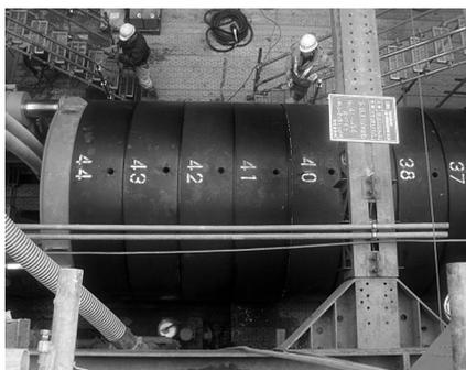
写真-7 右側 鋼・コンクリート合成管推進状況
