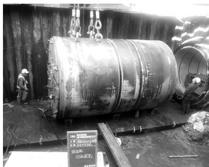
写真-8 右側 掘進機到達状況
