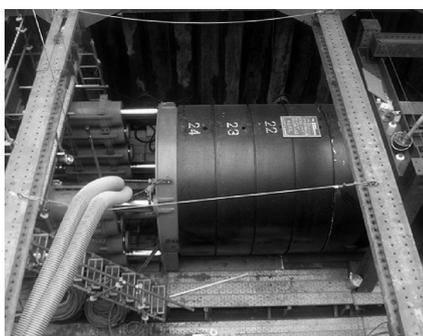
写真-4 左側 鋼・コンクリート合成管推進状況
