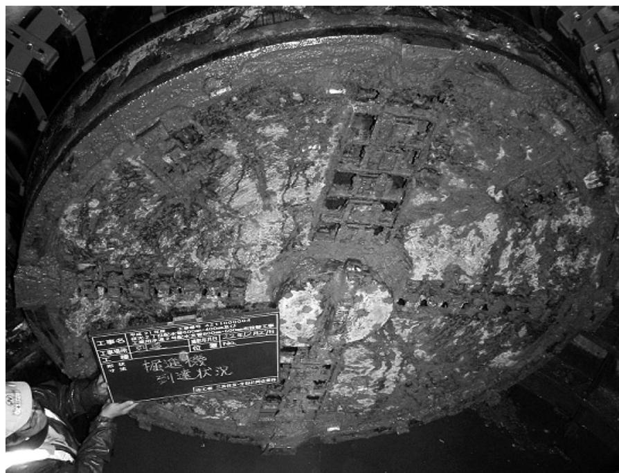
写真-5 掘進機到達状況
