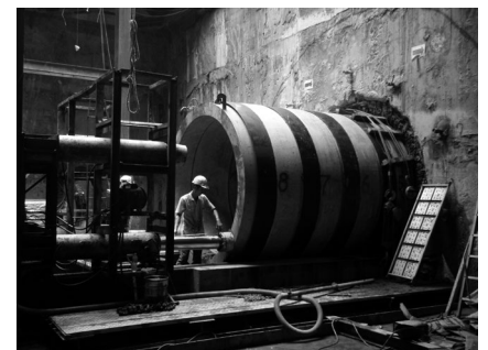
写真-9 1/3管の推進状況
