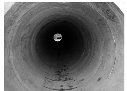
写真-10 貫通状況 (到達側より)
