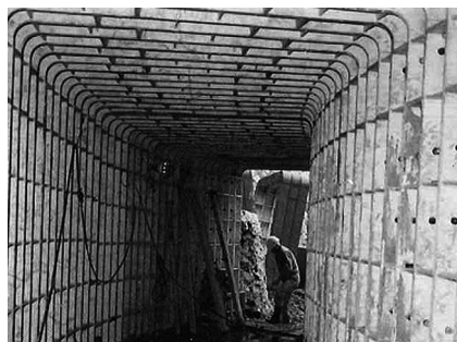
写真-1 混合推進(曲線部)
