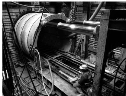
写真-11 元押ジャッキ上下配置
