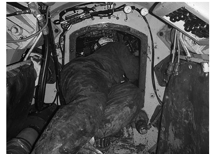
写真-5 点検扉開口、管内作業状況
