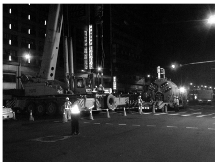
写真-1 掘進機搬入状況
