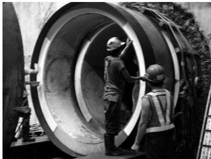
写真-4 センブラリング設置状況
