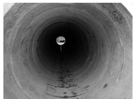
写真-7 貫通状況(到達側より)
