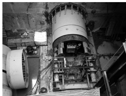
写真-2 掘進機挿入とダミー管
