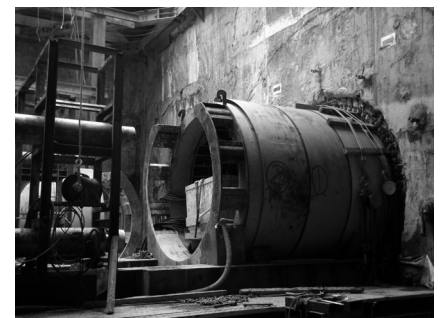
写真-3 ダミー管の推進状況
