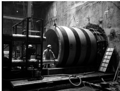
写真-5 1/3管推進状況
