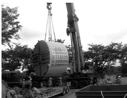
写真-5 掘進機投入状況
