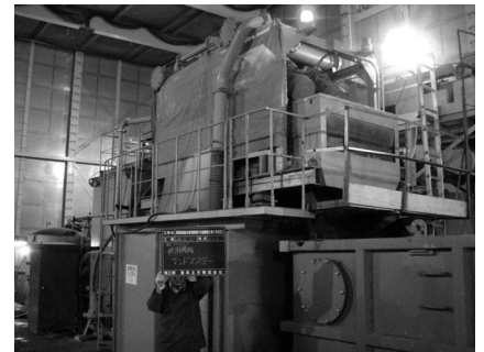
写真-7 防音壁内振動篩防振架台（内蔵タイプ）
