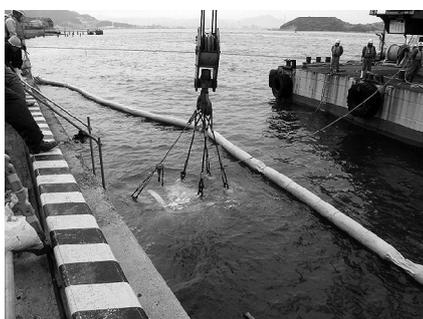
写真-12 掘進機回収状況
