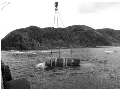
写真-9 掘進機回収状況
