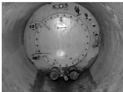
写真-10 第2隔壁 (水中回収システム)
