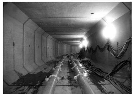
写真-7 推進中の函内状況 (曲線部)
