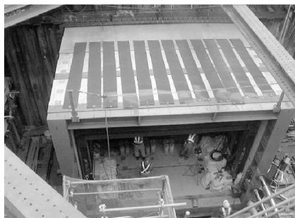
写真-6 カーテン鋼板の取付状況
