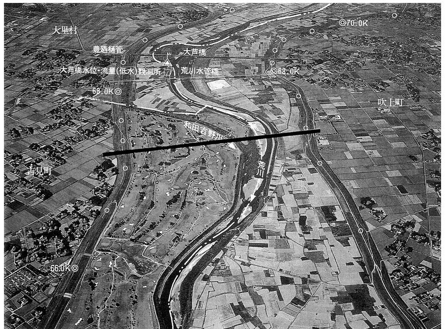
写真-3 施工位置
