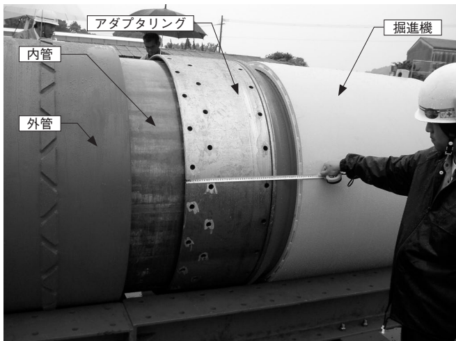
写真-4 外管から内管の抜け出し作動
