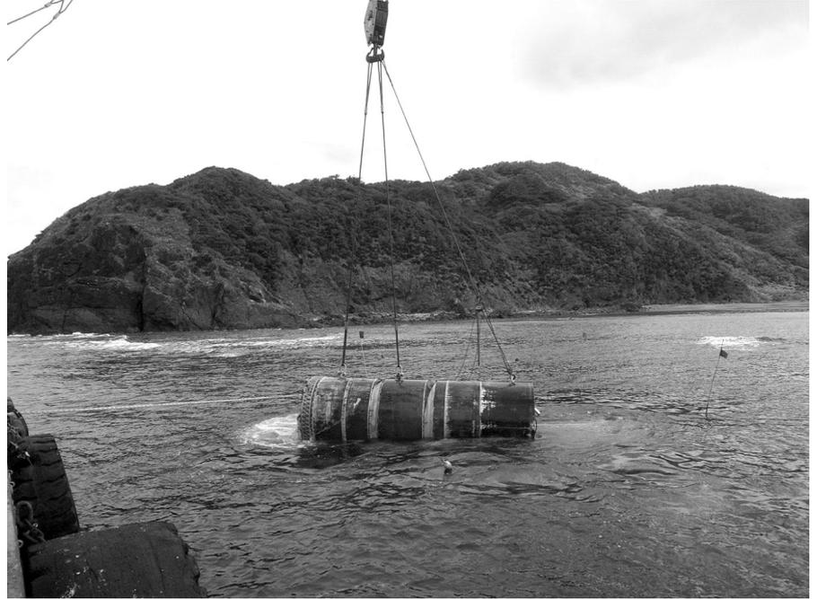
写真一4 掘進機回収状況
