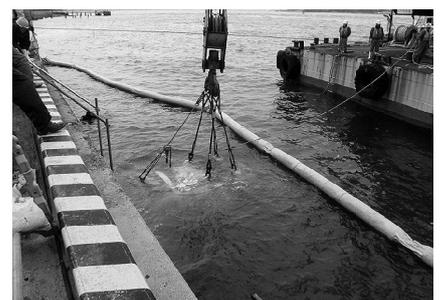
写真-7 掘進機回収状況
