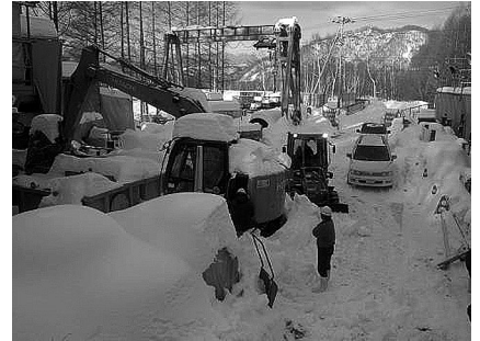
写真-11 降雪後の施工現場
