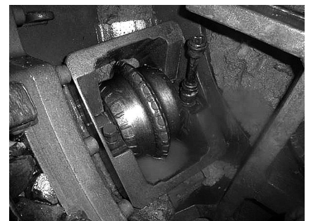
写真-5 外周部交換状況
