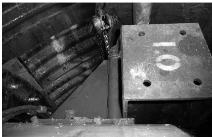
写真-2 バックキング金物取付状況
