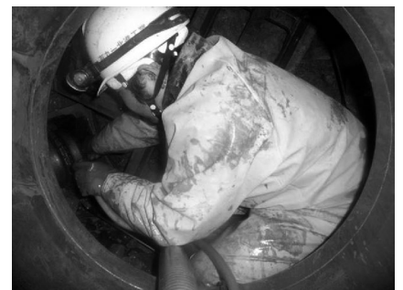
写真-3 ビット交換作業状況
