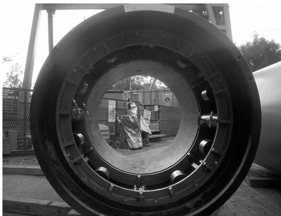
写真-7 中押しジャッキ組立(中間スリーブ)
