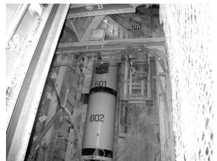
写真-1 2管推進用発進立坑・推進中
