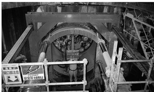
写真－7 Backing制御（外アンカ固定方式）
